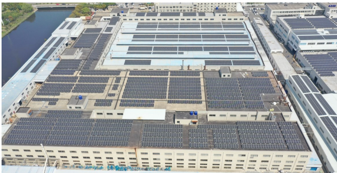
图 5 衢州杉杉新材料水泥屋顶项目
